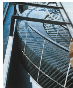
上水用フック式傾斜板 沈降分離装置 (押出プレート、耐衝撃プレート)
